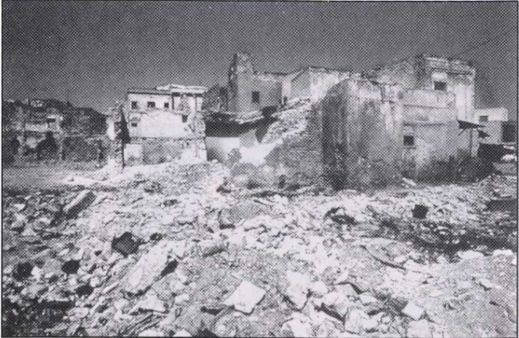
المباني المتصدعة والمتهدمة في منطقة حفصية.. حالة المنطقة قبل تنفيذ المشروع.
